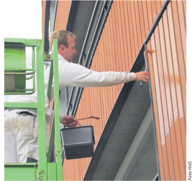
Voorman Niels behandelt het latwerk met Acrylic Stain, een impregneerbeits
