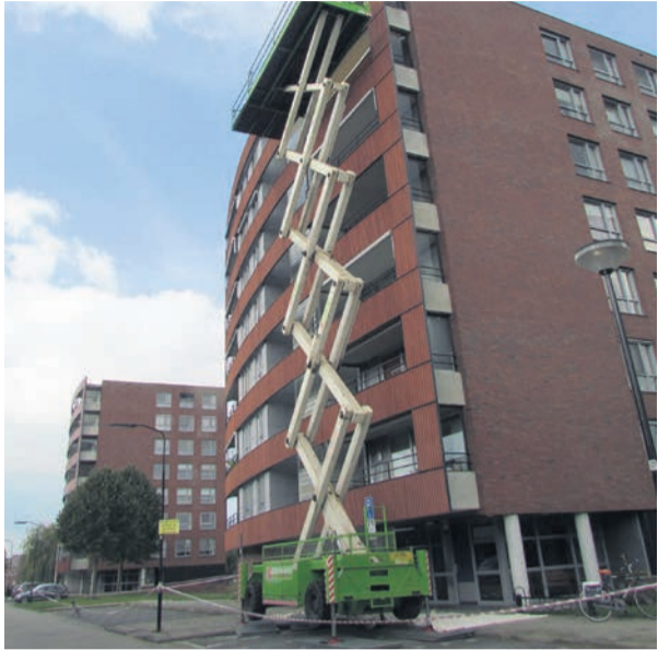
Een zware schaarlift was nodig om de voorzijde van het appartementencomplex bereikbaar te maken
